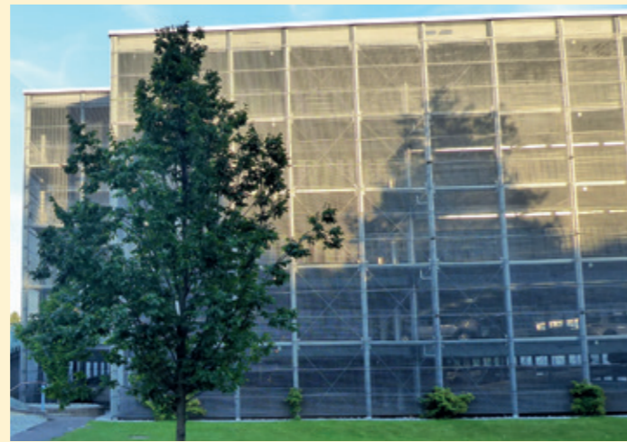
Das Parkhaus Jahnstraße verfügt nach der Erweiterung über 850 Stellplätze.
