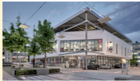
Von fgi entwickeltes und vermietetes Geschäftshaus in Göppingen.
