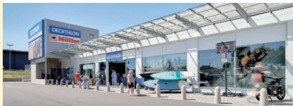
Revitalisierung im Fachmarktzentrum Iller-Center durch fgi.
